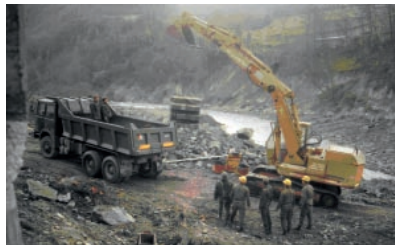
CANTIERE DI LAVORO DEL GENIO FERROVIARI.
