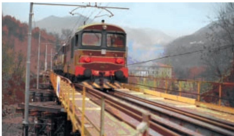
LA TRAVATA È STATA COLLOCATA POI È STATO RICOSTRUITO IL BINARIO, COLLAUDATO IL PONTE E AUTORIZZATO IL PASSAGGIO DEI TRENI.
