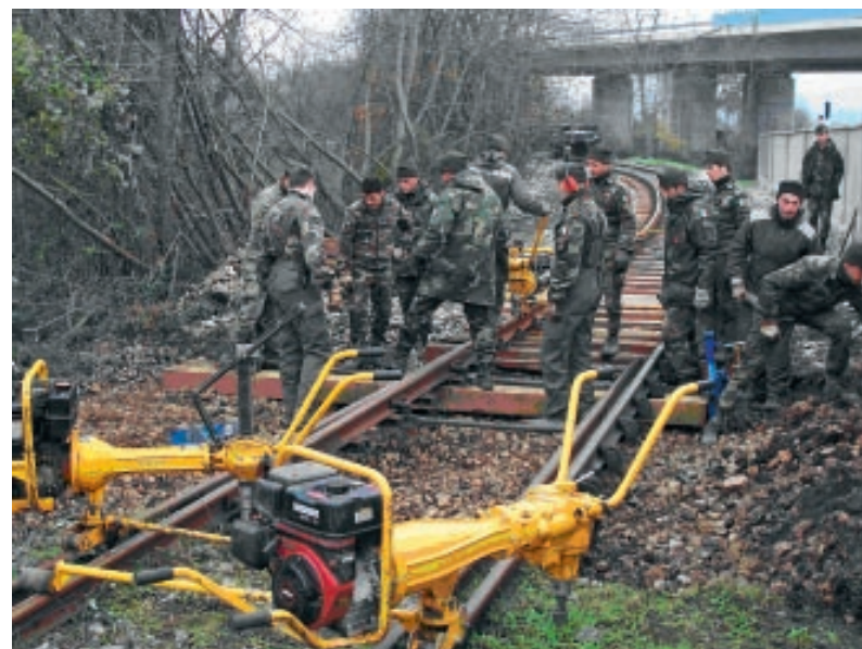
FASI DI RIPRISTINO DI UN BINARIO DA PARTE DEL GENIO FERROVIERI in LAVORI SUL TERRITORIO NAZIONALE.
