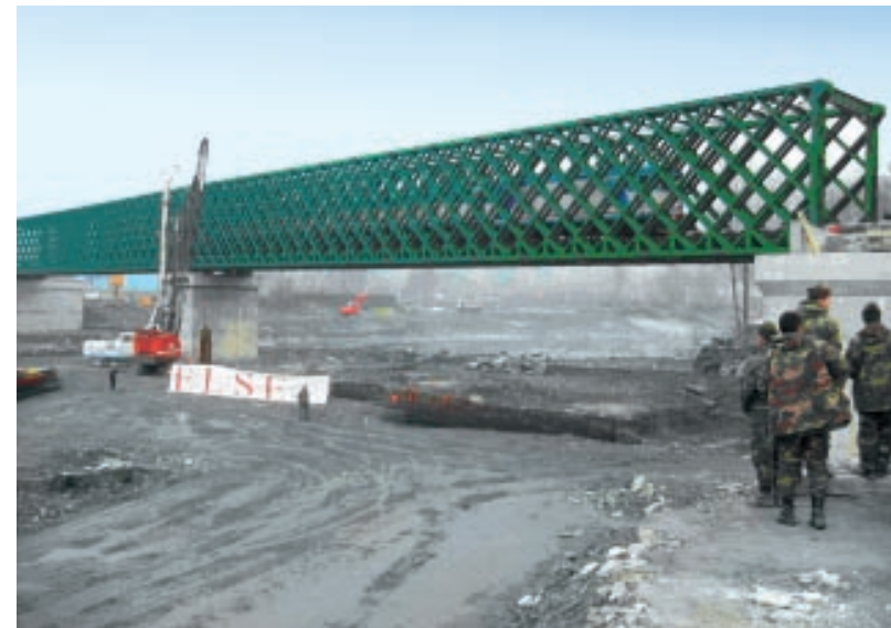
PONTE FERROVIARIO TIPO SE DELLA KRUPP REALIZZATO DAL GENIO FERROVIERI NEL 2002 A MONTESTRUTTO
