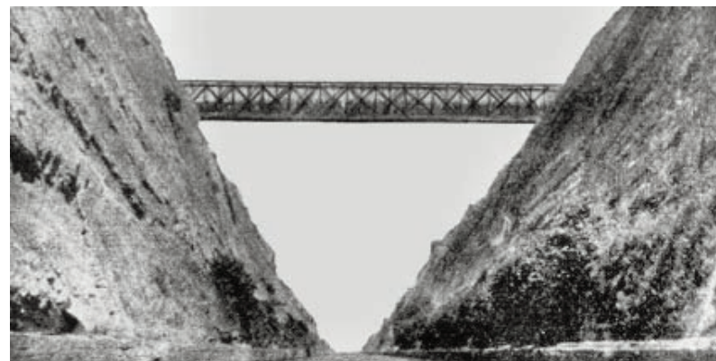
CANALE DELL'ISTMO DI CORINTO, PONTE METALLICO N. 3 (TIPO: ROTH – WAGNER) DI 84 METRI A SBALZO COSTRUITO DAL GENIO FERROVIERI A CIRCA OTTANTA METRI DI ALTEZZA SOPRA IL CITATO CANALE.
