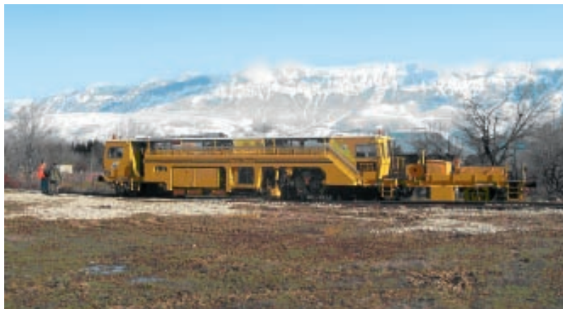
MACCHINA DELLA FS PER RINCALZARE LIVELLARE ALLINEARE IL BINARIO NEL RACCORDO FERROVIARIO MILITARE DI PRATOLA DELLA PELIGNA (AQ) 2003-2004.
