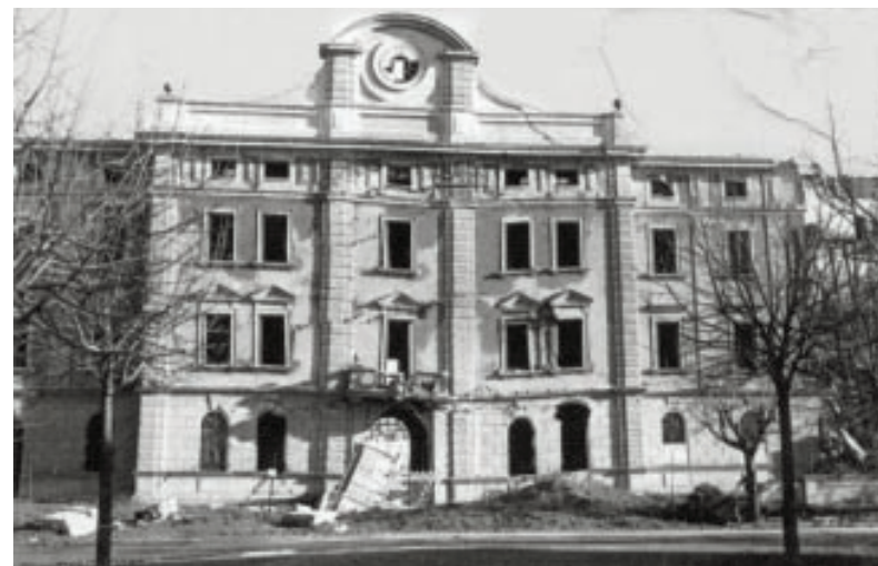
CASERMA DEL GENIO FERROVIERI DISTRUTTA DAI BOMBARDAMENTI DELLA SECONDA GUERRA MONDIALE. NELLA FOTO SUCCESSIVA PARTICOLARE DELLA CASERMA DISTRUTTA.
