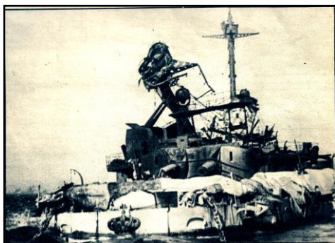
Due immagini del San Giorgio dopo l'esplosione
