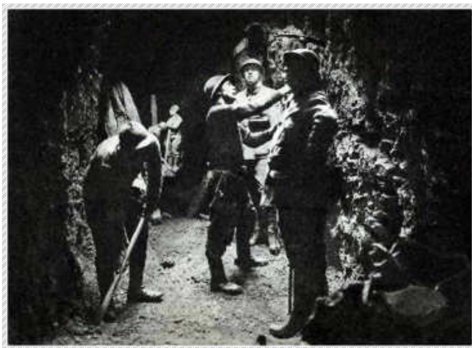
Fig. 6 – Scavo di una galleria di mina. Per il caricamento della camera di scoppio gli italiani usavano per lo più gelatina esplosiva a base di nitroglicerina
